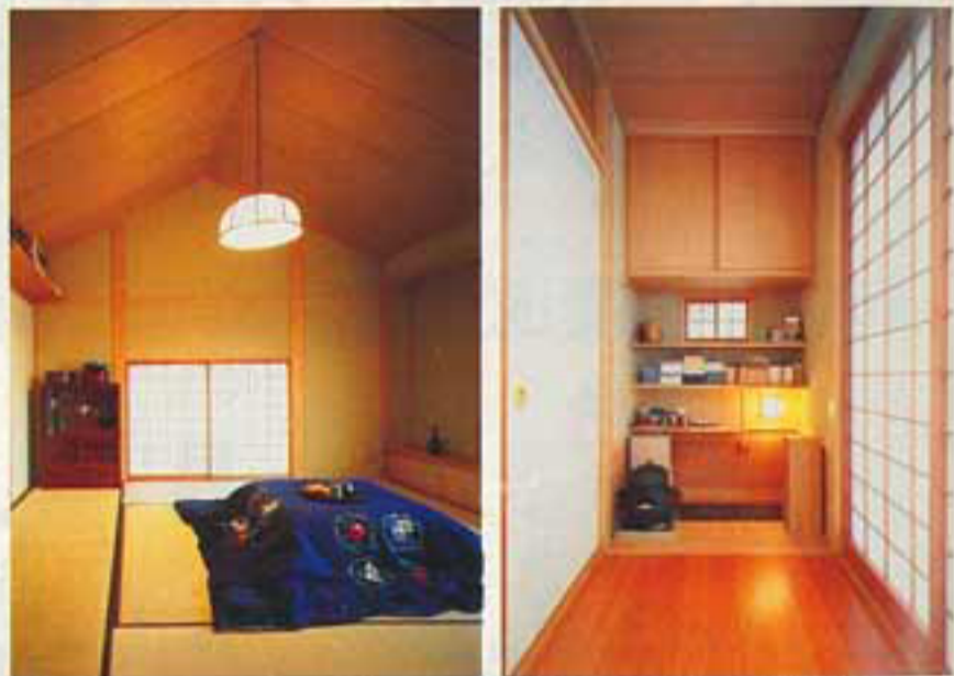
▲茶の間は客間につづいており襖をとり払えば一体的に使える 中央には掘りゴタツが設けてある 舟底天井は松合板張り
