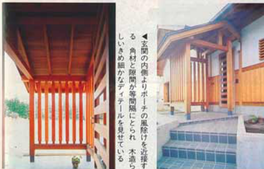
▲ポーチにはヒバの角材を縦格子状に囲った風除けを設けている 小さな外空間だが屋根や柱の木組みも母屋と変わらない本格的な納まり
